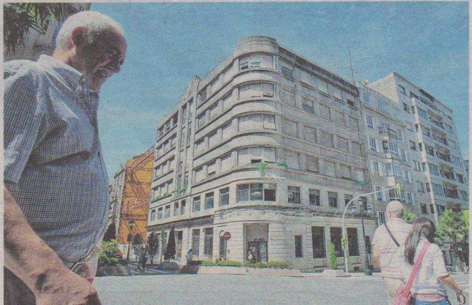
Colón con Marqués de Valladares. A pesar de su abandono, este edificio no fue alterado con modificaciones posteriores. Tiene elementos art-decó en su remate y en el portal. La mezcla de hormigón y cantería de piedra será repetida en otras ocasiones por Francisco Castro. ÓSCAR VÁZQUEZ
